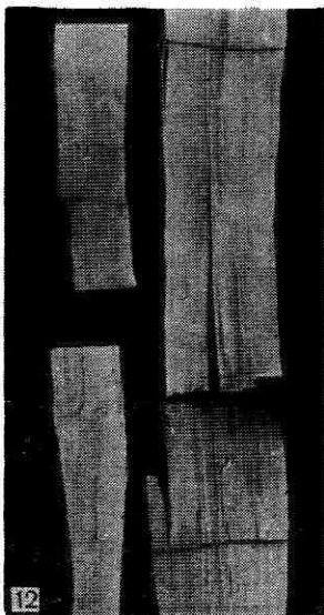
Rys. 12. Żerowisko larwy i otwór wylotowy owada zbliżone do żerowiska i otworu wylotowego dzisiejszego gatunku Trypodendron lineatum L. (fot. S. Kinelski)
