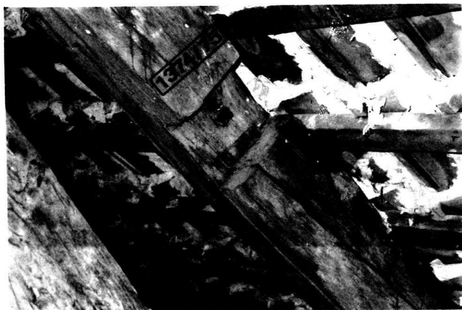
Rys. 3. Powtórnie użyty element konstrukcyjny więźby dachowej kościoła w Starzyńie z widocznymi śladami pierwotnego zastosowania
